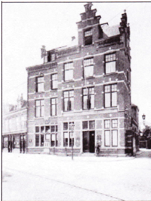
Scheveningen Badhuisstraat Sub-postoffice
